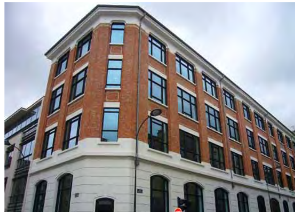
LA RÉHABILITATION DE L'ANCIENNE USINE CONSTRUITE VERS 1930, sis 24-26 rue Villeneuve.
